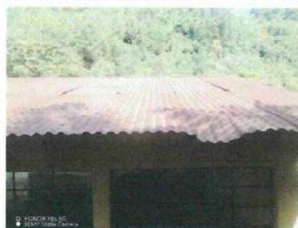
Foto 4: Sustitución del techo por lámina troquelada en el edificio principal
