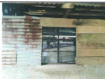
Foto 6: Sustitución de ventana en la cocina
