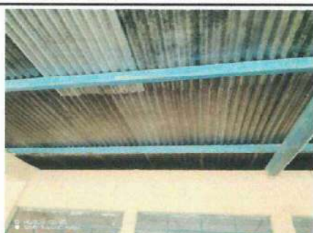
Foto 5: Mantenimiento de costaneras del techo del edificio principal
